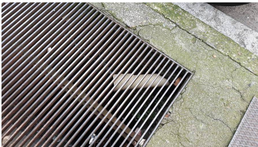
Fotografia 2 – Le griglie hanno generalmente un elemento di rinforzo centrale
